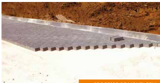
PROCESSO DE MONTAGEM
