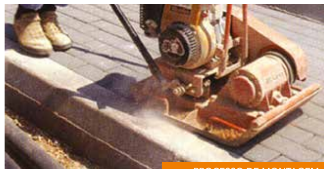
PROCESSO DE MONTAGEM
