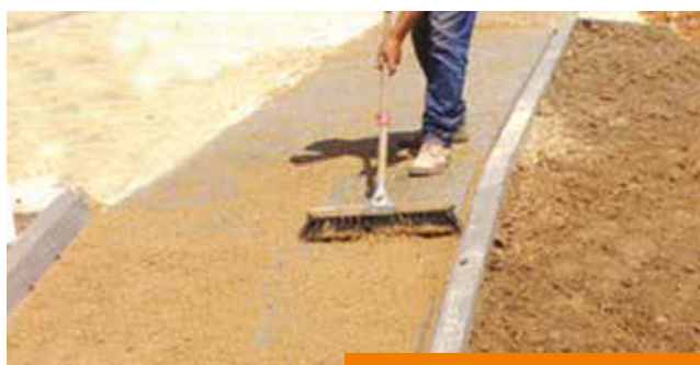
PROCESSO DE MONTAGEM
